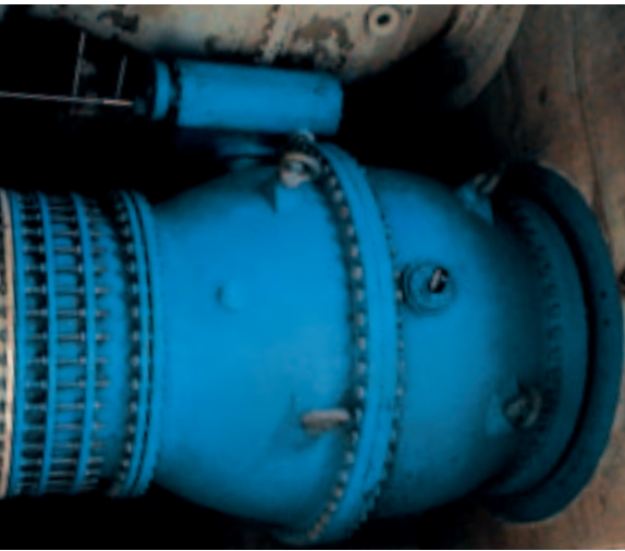
Der Ringkolbenschieber im eingebauten Zustand The flow control valve, axial piston type, in installed position
