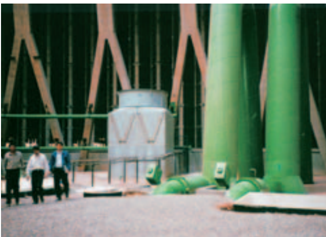
Absperrklappe mit hydraulischem Fallgewichtsantrieb bei der Abnahme ... Butterfly valve with hydraulic drop- weight actuator at time of inspection ...
