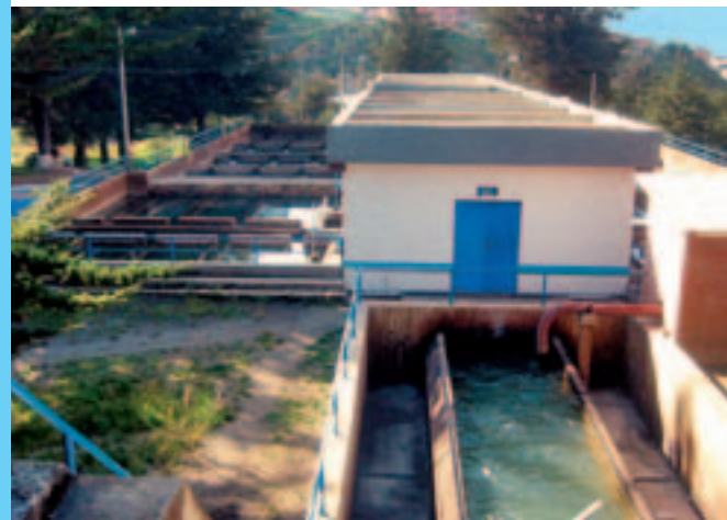
Die Planta Achachicala sorgt für die Wasserversorgung von La Paz. The Planta Achachicala ensures the water supply for the city of La Paz.
